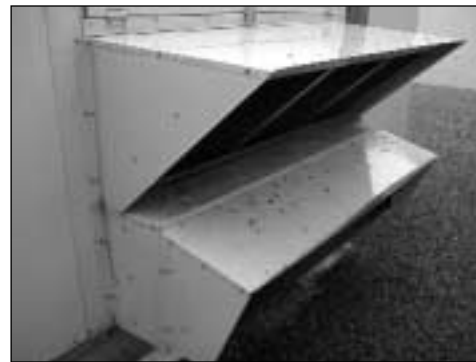
Figure 2 Excréments d'oiseaux près de la prise d'air neuf
