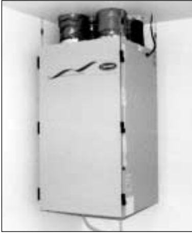
Figure 9 – Échangeur de chaleur
